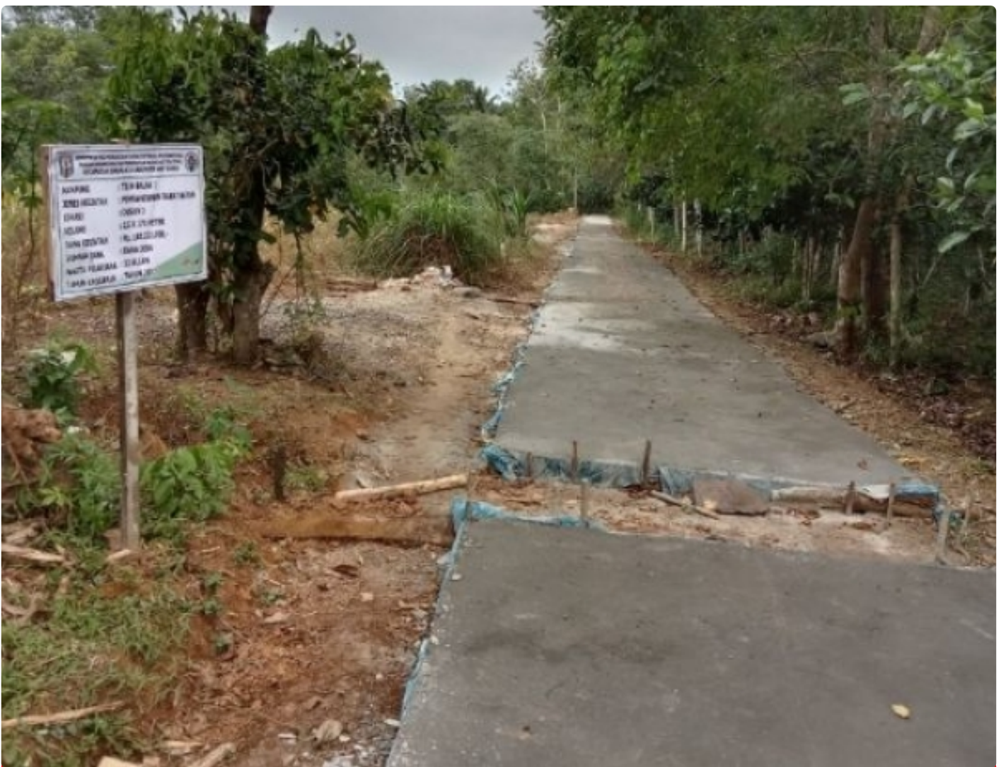
Pembangunan Rabat Beton yang terletak di Dusun Dua Kampung Tiyuh Balak Satu dengan sumber anggaran Dana Desa (APBN) Tahun 2022
