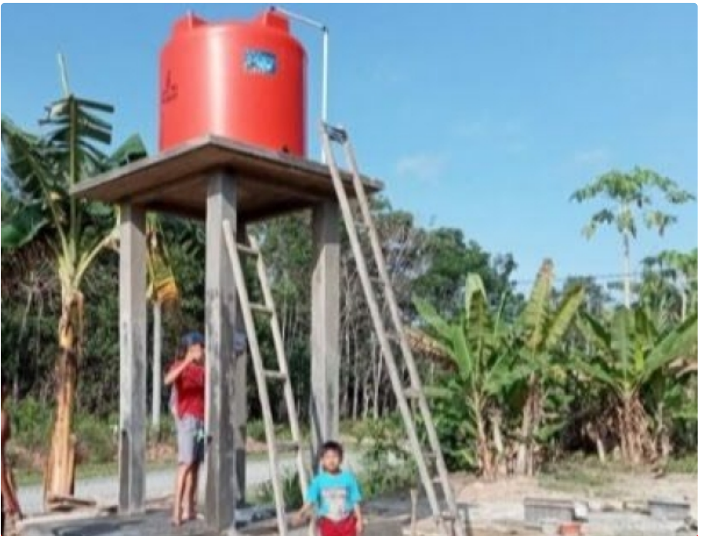
Pembangunan sumur bor di Desa Fajar Baru
