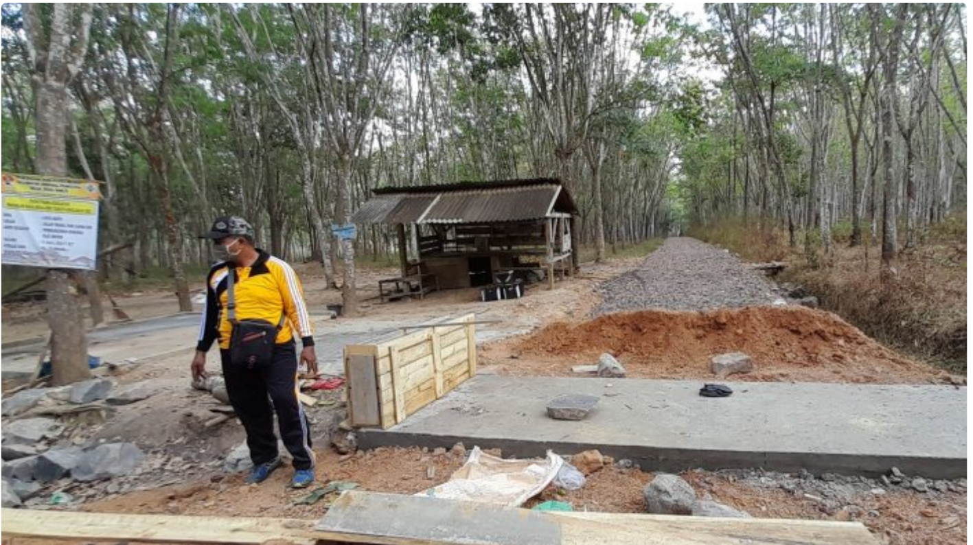
Kepala Desa Jaya Sakti Monitoring Pembangunan
